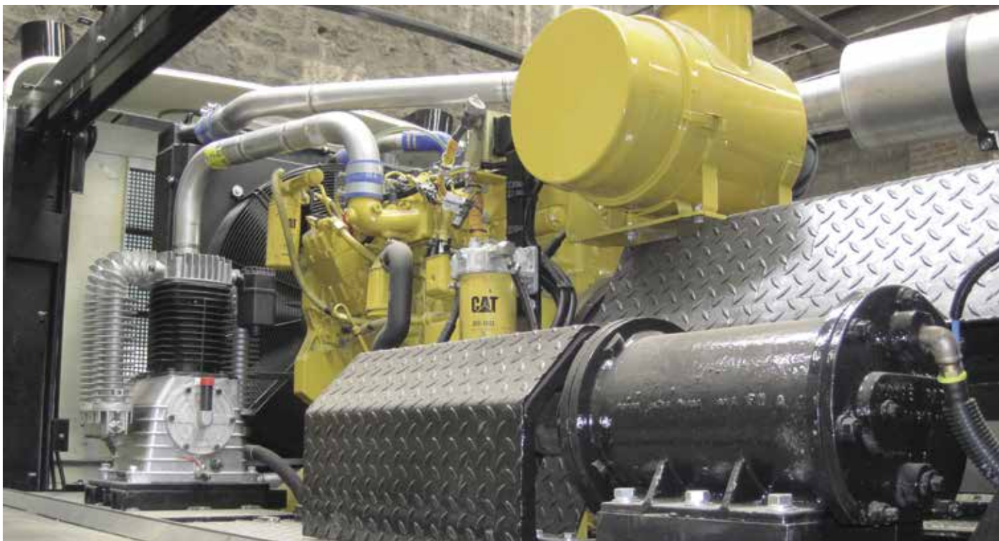
Compartiment moteur après rénovation Complete engine after renovation
