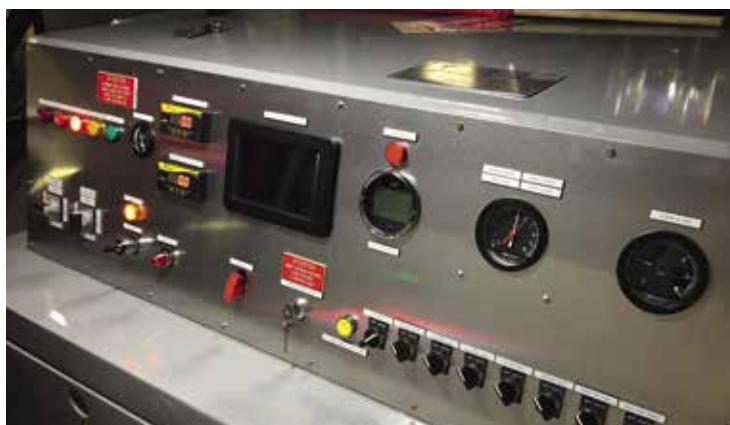
Pupitre rénové sur locotracteur Fauvet Girel Refurbished Drive control desk of a locomotive Fauvet Girel
