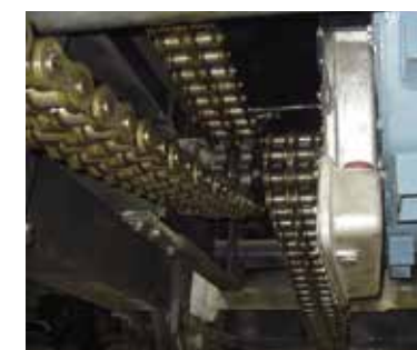
Remplacement des chaînes Chain replacement
