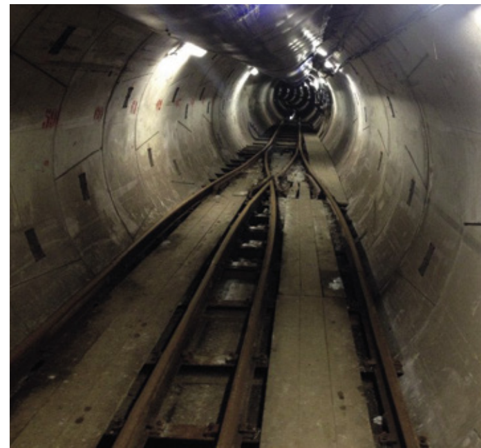
Aiguillage symétrique Symmetrical switch
