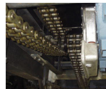
Remplacement des chaînes Chain replacement
