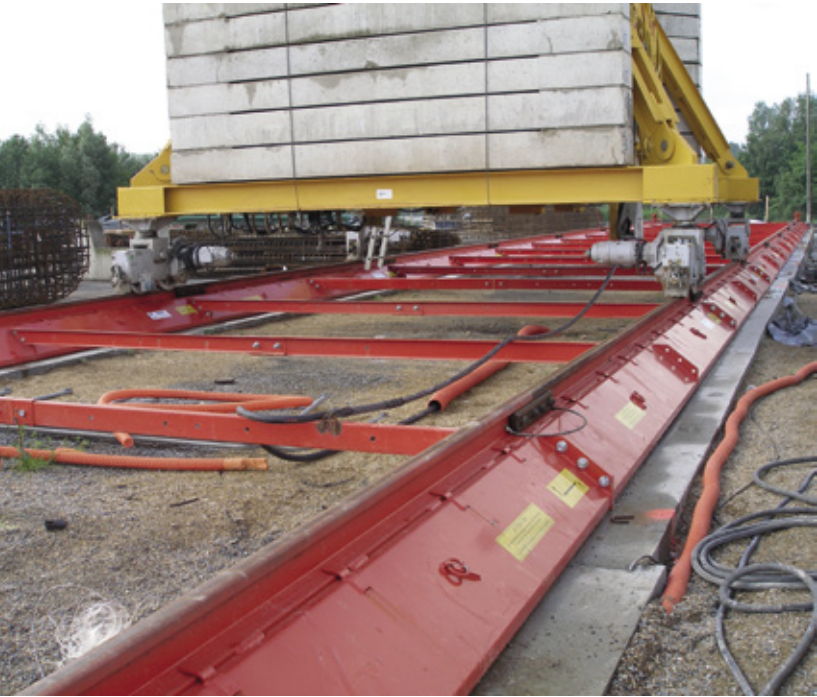
Entretoises réglables pour un écartement de voie de 4,5 à 9 mètres. Adjustable spacers for gauge from 4,5 to 9 meter
